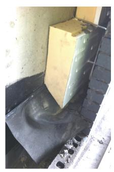
CUT INSULATION AROUND CAVITY TRAY
