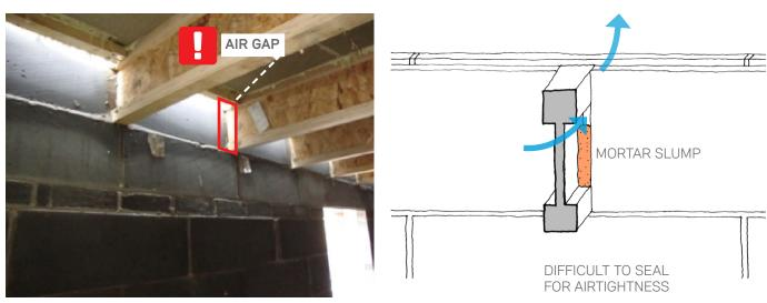
MORTAR WILL NOT BE AIRTIGHT AROUND JOISTS
